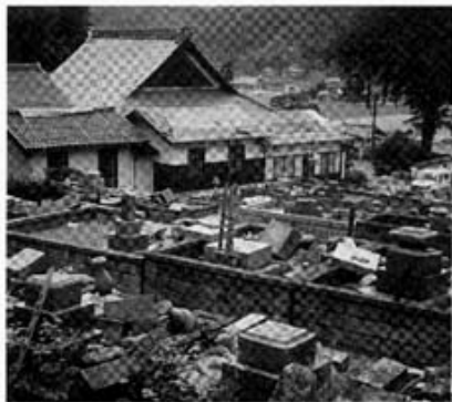
倒壊した墓地
