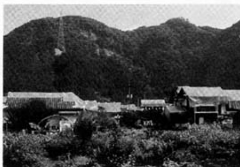
奥の山は崩れ、屋根の瓦が壊れビニールシートを張っている
