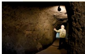
当時の面影を残す洞門。手彫りのノミ跡が壁面に残る
