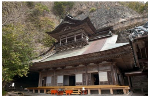
本堂●焼失後、昭和44年(1969年)に再建。銅板葺きの屋根の上に小さな楼閣を載せた造形が珍しい
