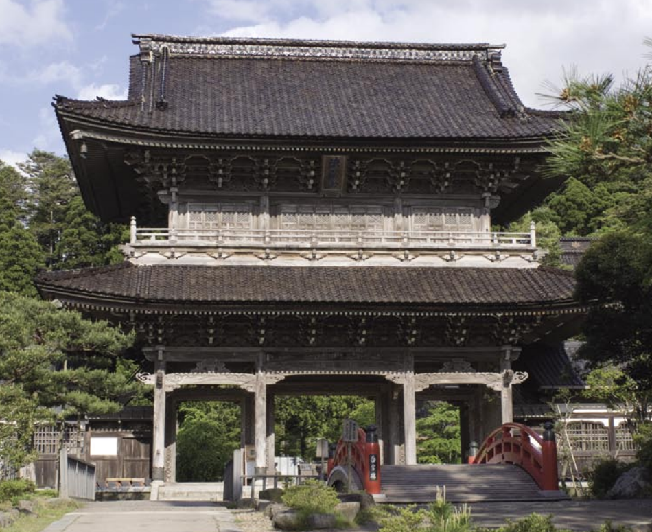
【山門(さんもん)】 焼失後、昭和七年(1932年)に再建された。高さ17.4m、間口20m、奥行14.4mの堂々とした入母屋造りで、荘厳さの中にも巧みな繊細さが美しい。楼上には観音像、地藏像、五百羅漢像が奉られている。総櫓造り。
