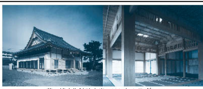
芳ヶ崎市前院本堂 2004年2月 竣工
