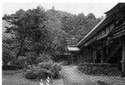
手前、保存修理の完了した「庫裡と鐘樓」奥、現在修理工事中の「法堂」共に国重要文化財
