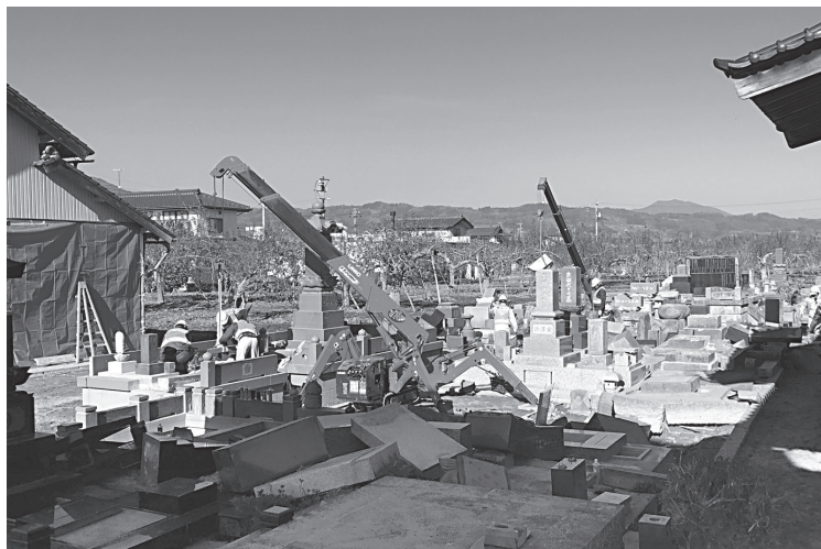
倒れた墓石の復旧作業
