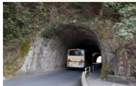
現在の青の洞門。この右側(川側)に旧洞門の一部が残されている
