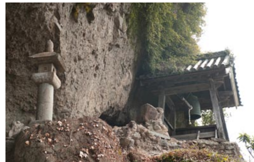
本堂手前の急峻な崖地に建つ鐘楼。ここからの眺めは絶景だが登るには危険が伴う
