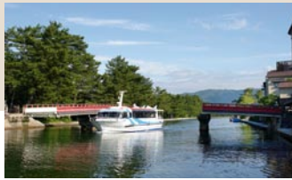
天橋立の運河に架かる「廻旋橋」。橋桁が低いため船が通る際、橋が廻旋して開く
